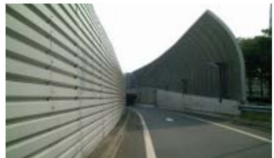
遮音壁（外環 和光地区）
