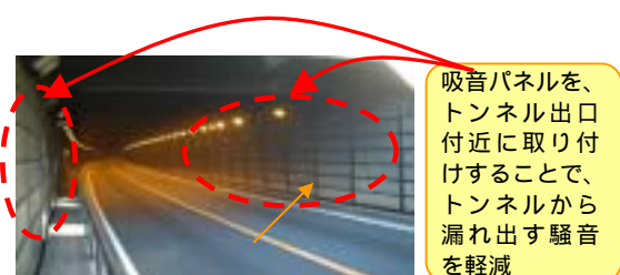
トンネル内の吸音処理
