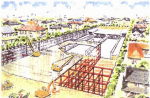
開削工法工事のイメージ図
