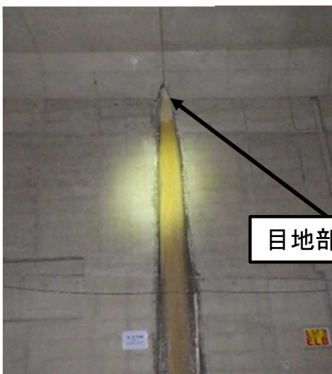
写真①:車道階 側壁部
