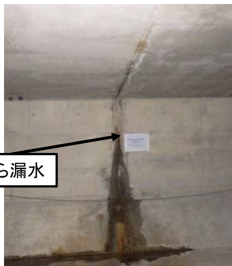
写真②:避難通路階 側壁部
