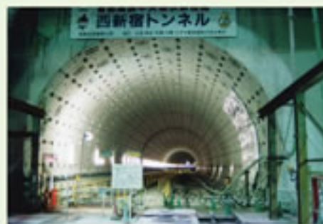
●シールドトンネルの施工状況の例 (首都高速中央環状新宿線)
