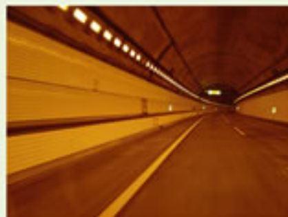
●供用しているシールドトンネルの例 (東京湾アクアライン)
