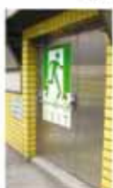
首都高速中央環状新宿線の例
