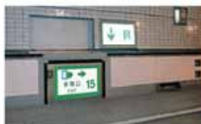
路面下への非常口(路面から)
