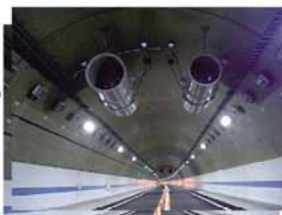
写真:近畿自動車道(紀勢線)高田山トンネル 左:口径 1250mm φ型 右:口径 1000mm φ型
