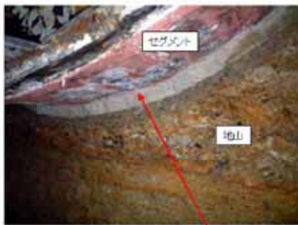
漏水防止の裏込め材
