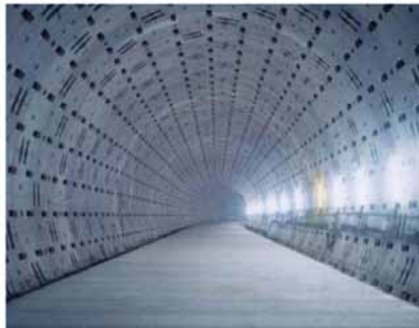
密閉型シールドトンネルの工事例
