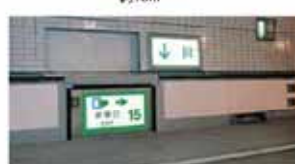
路面下への非常口(路面から)
