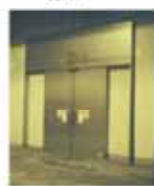
上下線連絡坑口
