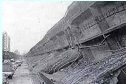
資料:国土交通省阪神国道事務所 (神戸市東灘区深江 3号神戸線)
