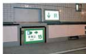
路面下への非常口(路面から)
