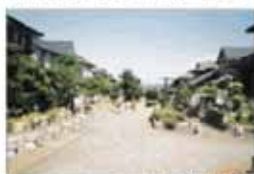
無電柱化・緑化等
