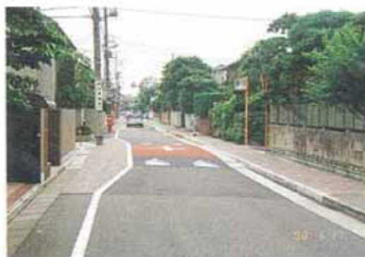
ハンプの設置状況
