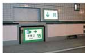
路面下への非常口(路面から)
