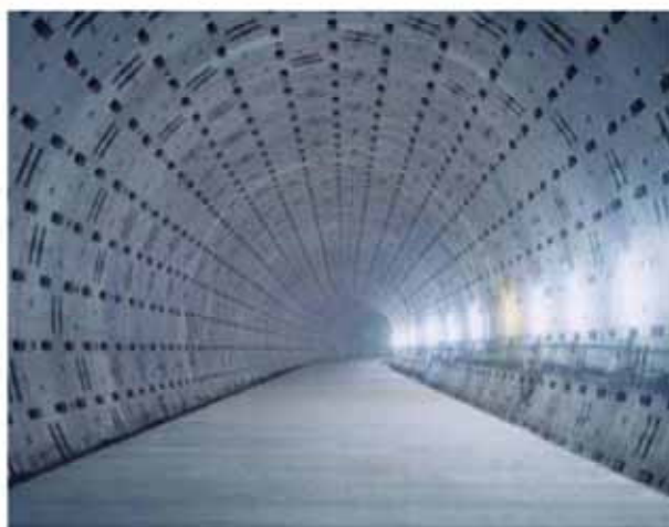
密閉型シールドトンネルの工事例
