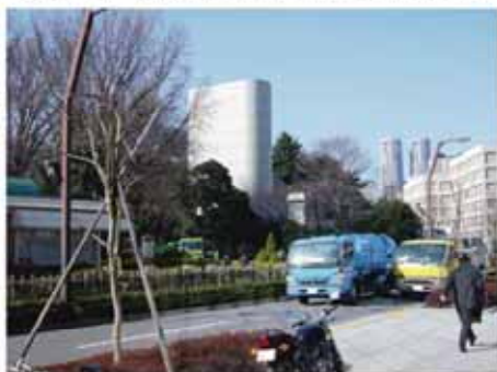
国道 20 号 新宿御苑換気所
