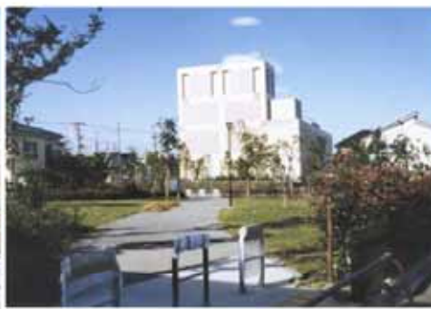
圏央道 青梅トンネル換気所緑地
