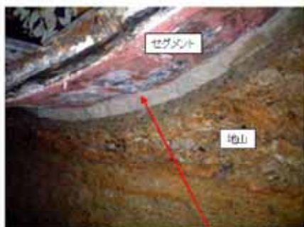
漏水防止の裏込め材
