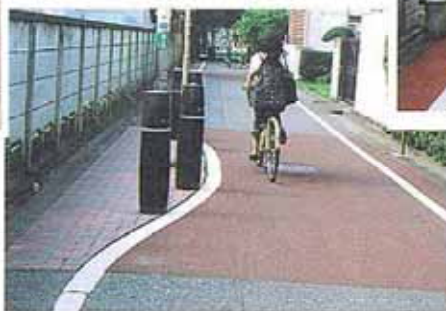
ボード(狭さく)の設置
