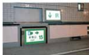
路面下への非常口(路面から)
