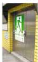
首都高速中央環状新宿線の例
