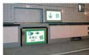
路面下への非常口(路面から)
