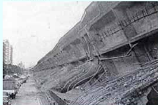
資料:国土交通省阪神国道事務所 (神戸市東灘区深江 3号神戸線)
