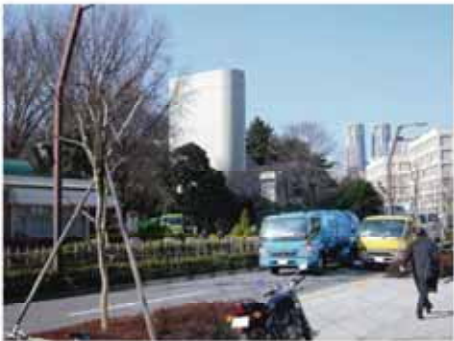
国道 20 号 新宿御苑換気所
