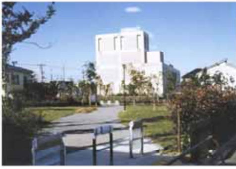
圏央道 青梅トンネル換気所緑地
