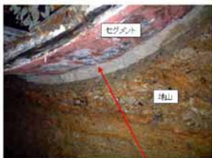
漏水防止の裏込め材
