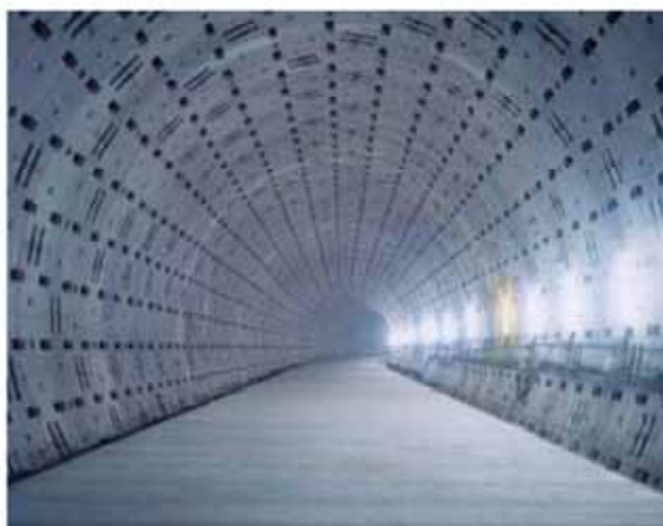
密閉型シールドトンネルの工事例
