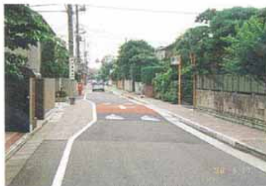
ハンプの設置状況
