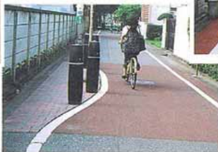
ボード(狭さく)の設置
