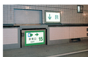
路面下への非常口（路面から）
