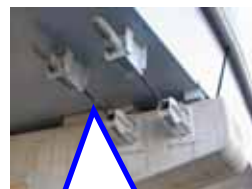
落橋防止構造
