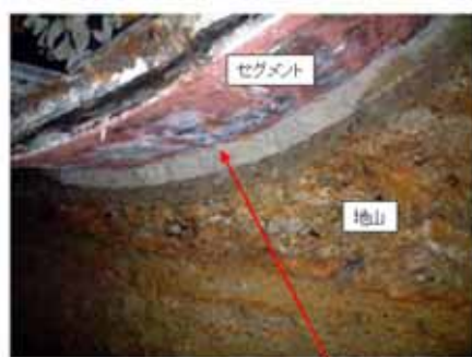
漏水防止の裏込め材
