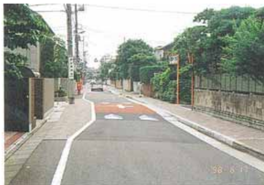
ハンプの設置状況
