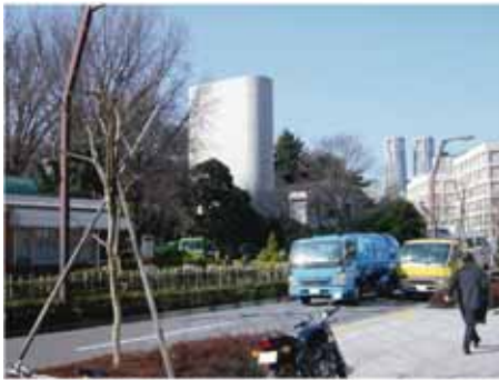
国道 20 号 新宿御苑換気所
