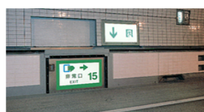
路面下への非常口（路面から）
