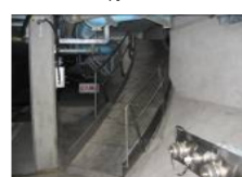
すべり台（路面下から）
