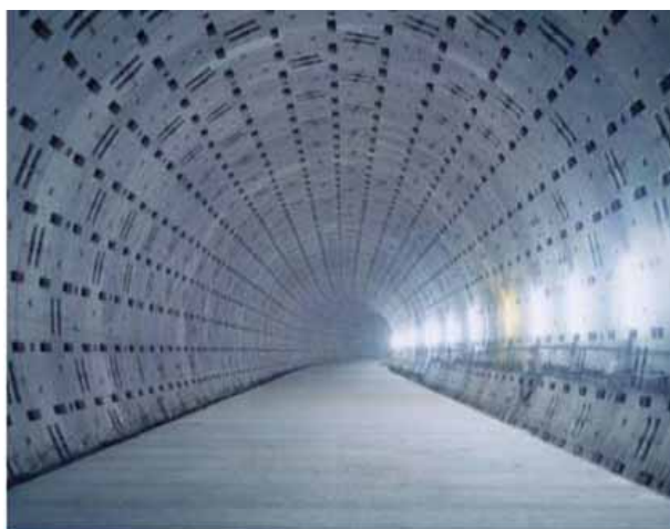
密閉型シールドトンネルの工事例
