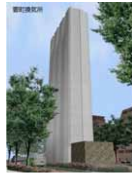
首都高速中央環状新宿線 要町換気所 資料：首都高速道路 ホームページ
