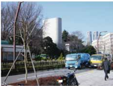
国道 20 号 新宿御苑換気所
