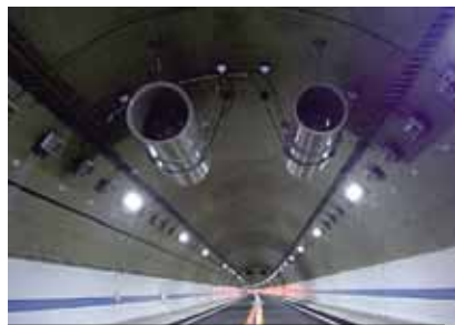
写真:近畿自動車道(紀勢線)高田山トンネル 左:口径 1250mmφ型 右:口径 1000mmφ型
