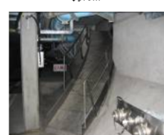
すべり台（路面下から）
