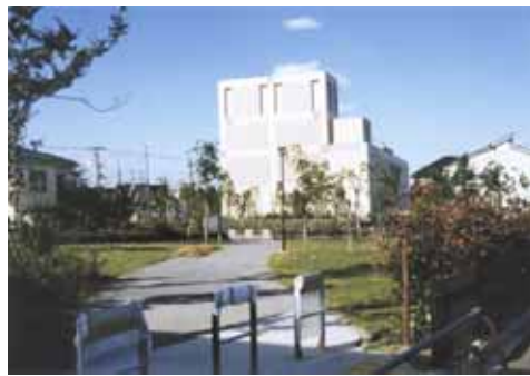
圏央道 青梅トンネル換気所緑地
