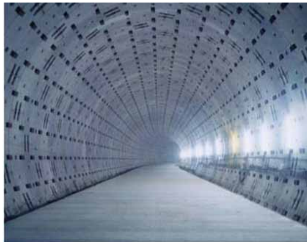
密閉型シールドトンネルの工事例
