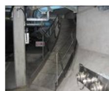
すべり台（路面下から）
