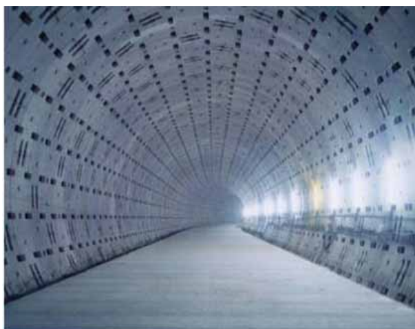
密閉型シールドトンネルの工事例
