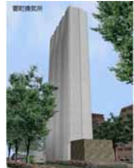
首都高速中央環状新宿線 要町換気所 資料：首都高速道路 ホームページ
