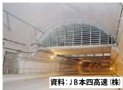
写真：神戸淡路鳴門自動車道 舞子トンネル 電気集じん機室（天井設置型）送気口
