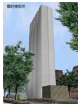
首都高速中央環状新宿線 要町換気所 資料：首都高速道路 ホームページ
