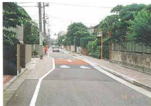
ハンプの設置状況
