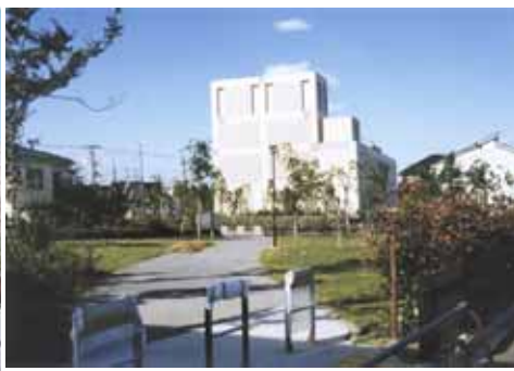
圏央道 青梅トンネル換気所緑地
