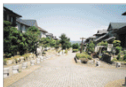
無電柱化・緑化等
