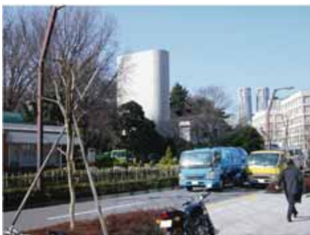
国道 20 号 新宿御苑換気所
