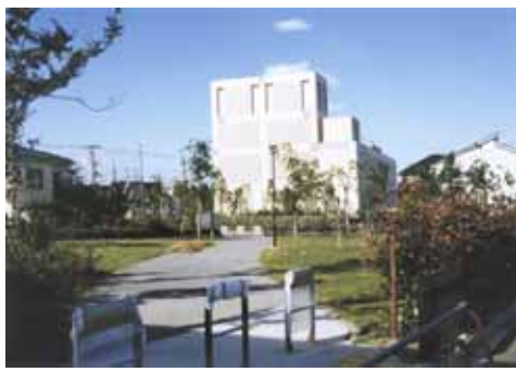
圏央道 青梅トンネル換気所緑地
