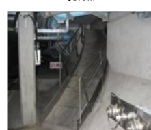
すべり台（路面下から）
