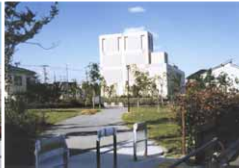
圏央道 青梅トンネル換気所緑地
