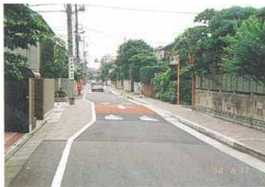
ハンプの設置状況
