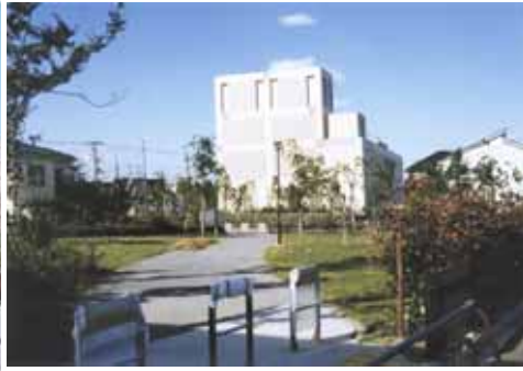
圏央道 青梅トンネル換気所緑地
