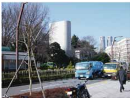
国道 20 号 新宿御苑換気所
