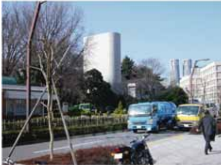
国道 20 号 新宿御苑換気所
