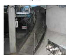
すべり台（路面下から）
