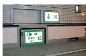
路面下への非常口(路面から)
