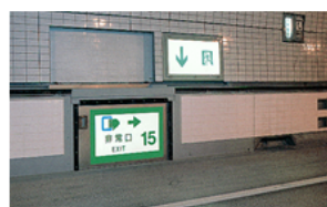
路面下への非常口（路面から）
