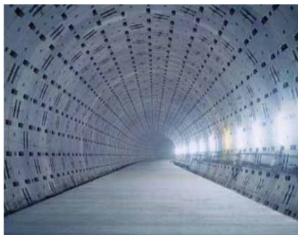
密閉型シールドトンネルの工事例
