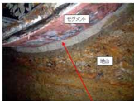
漏水防止の裏込め材
