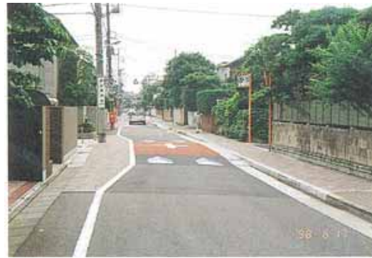
ハンプの設置状況
