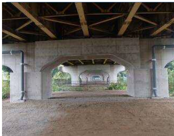
国道16号 中里跨道橋 完成
