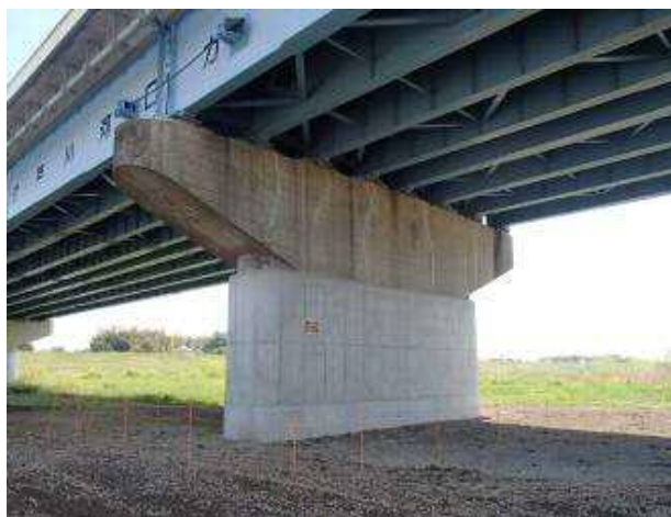
国道16号 金野井大橋P3橋脚 完成
