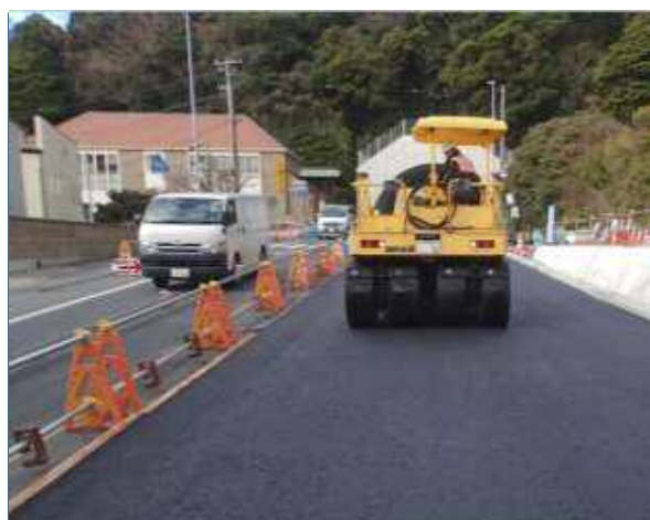
車道舗装締固め状況
