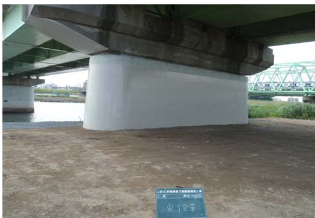
完成(P4橋脚)
