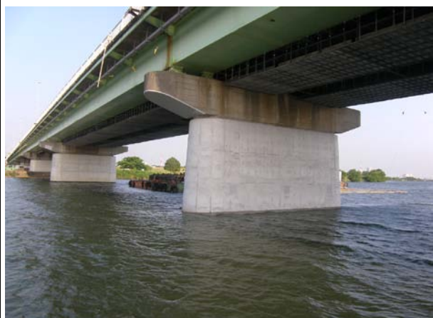
完成(P2橋脚)
