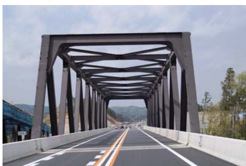
大和田第一橋
