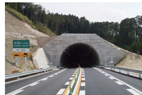
山辺トンネル
