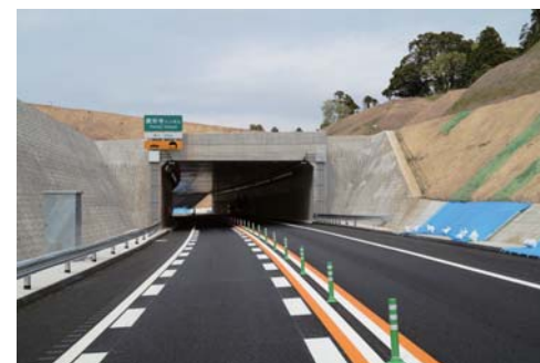
養安寺トンネル
