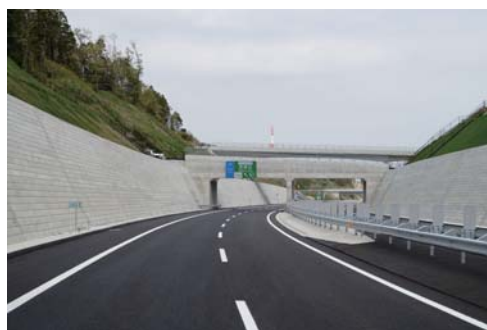
茂原北インターチェンジ
