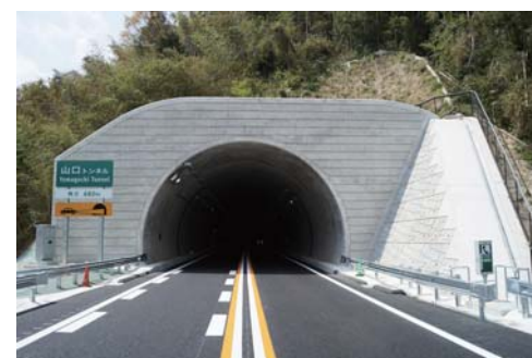
山口トンネル
