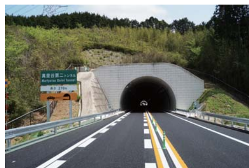
真里谷第二トンネル
