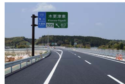
木更津東インターチェンジ
