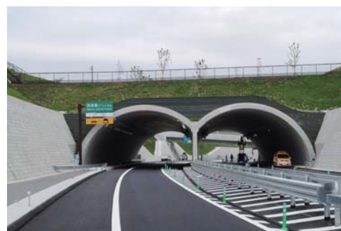
茂原第一トンネル
