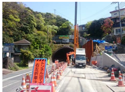
坂下トンネル(拡幅)
