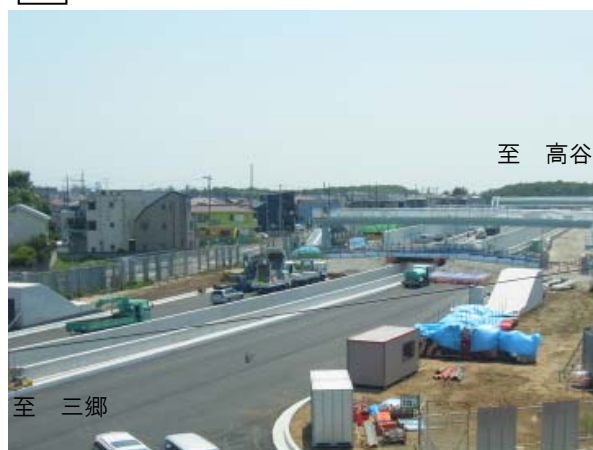
B いちかわ ほりのうち ちく かんきょ こうじ 市川市堀之内地区函渠工事
