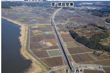
H25.5.31 暫定開通区間
