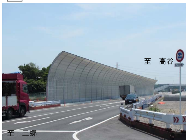
C いちかわ たじり こうや ちく しゃおんへき こうじ 市川市田尻高谷地区遮音壁工事
