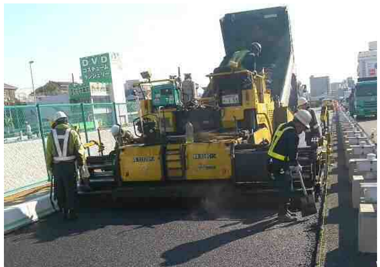
オーバーレイ（敷均し）状況
