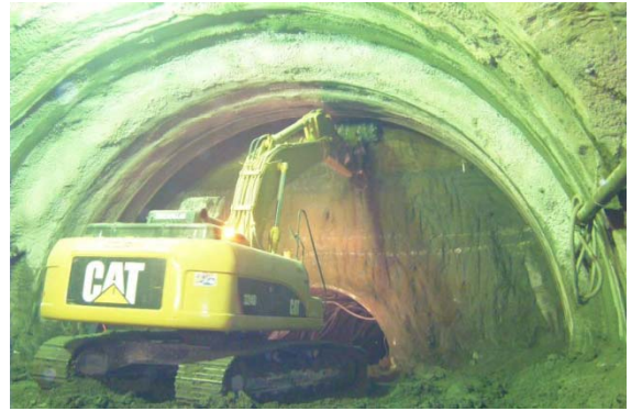
・終点側上半掘削状況
