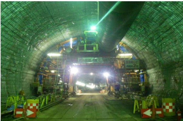
・起点側覆エコンクリート施工状況
