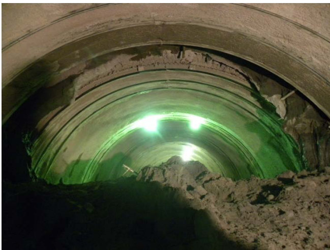
・起点側貫通状況
