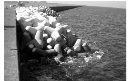
ブロック据付完了部(一部)
