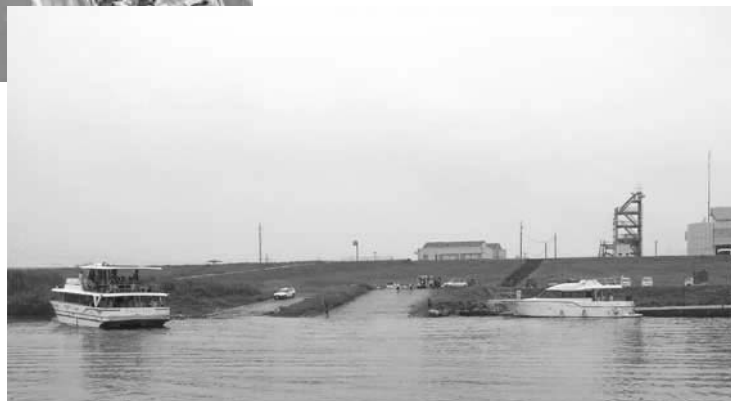
船着場既設(栄町出津地先)
