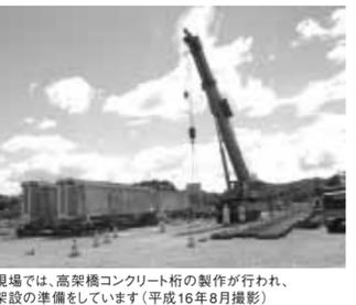
現場では、高架橋コンクリート桁の製作が行われ、架設の準備をしています (平成16年8月撮影)
