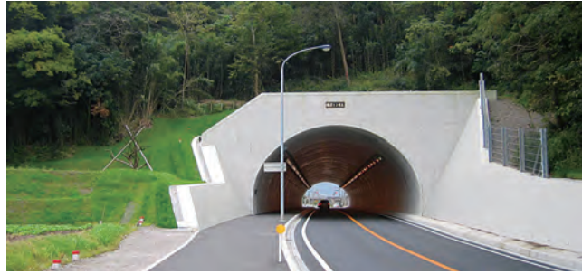
勝岩トンネル
