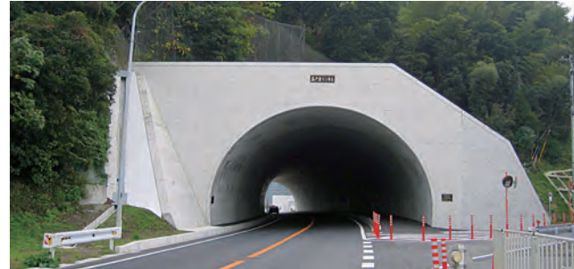
島戸倉トンネル
