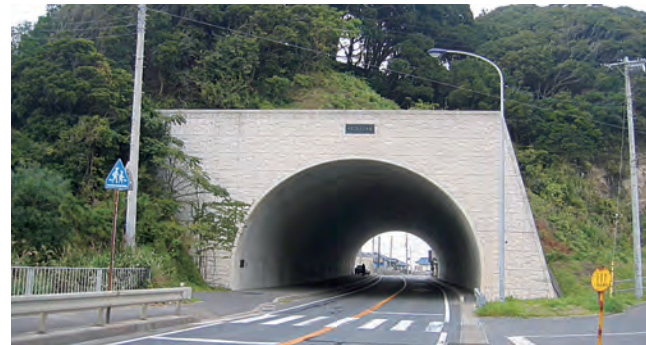
打越トンネル
