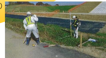
(水路断面形状の確認状況→)
