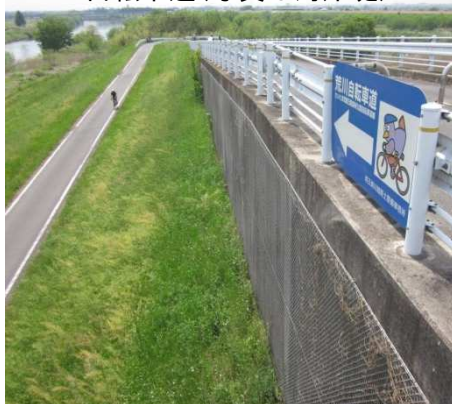
自転車道(写真は対岸堤)
