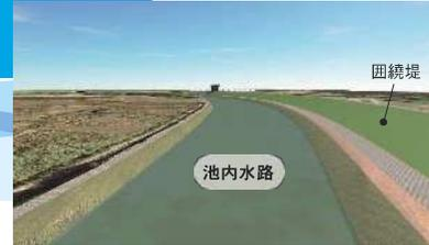
普段は調節池の中に降った雨を集めて排水し、洪水時は調節池内にためた水を排水する水路です。
