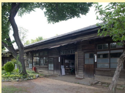
兵舎（宿舎）棟外観
