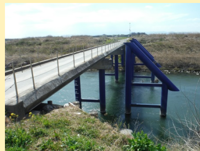
鋼製の流木除けのある冠水橋
