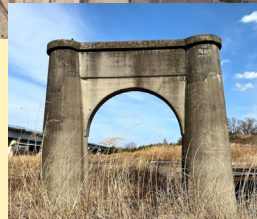
旧上江橋橋脚
