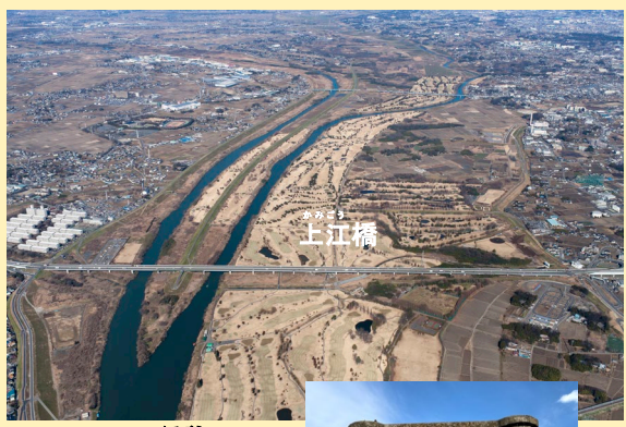
上空から見た上江橋
