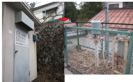
三峯雨量観測所
