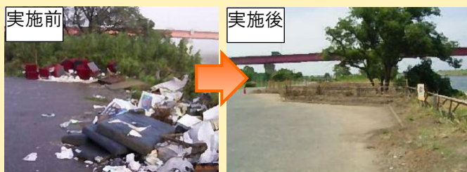
秋ヶ瀬橋付近の状況
