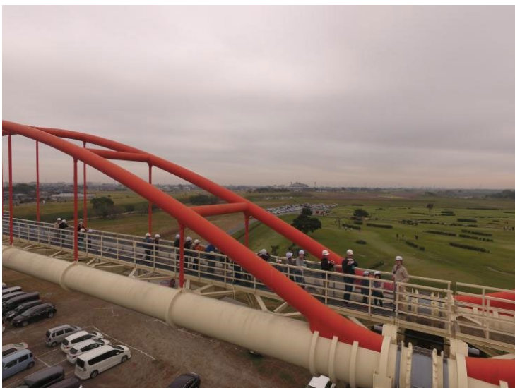
あら すいかんきょう 荒川水管橋
