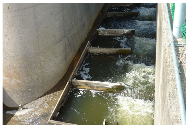
あき が せ し ゅ す い せ き ぎやうどう 秋ヶ瀬取水堰には魚道も設置されています
