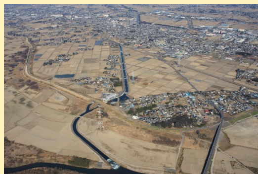
むさしすいろう 武蔵水路
