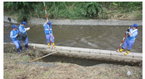
災害派遣要請を受け、堤防等の被災調査を行う 荒川上流河川事務所職員
