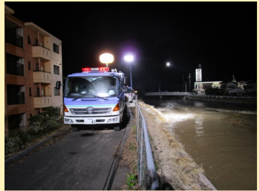
2015(平成27)年9月関東・東北豪雨 派遣先の排水作業の様子(常総市)
