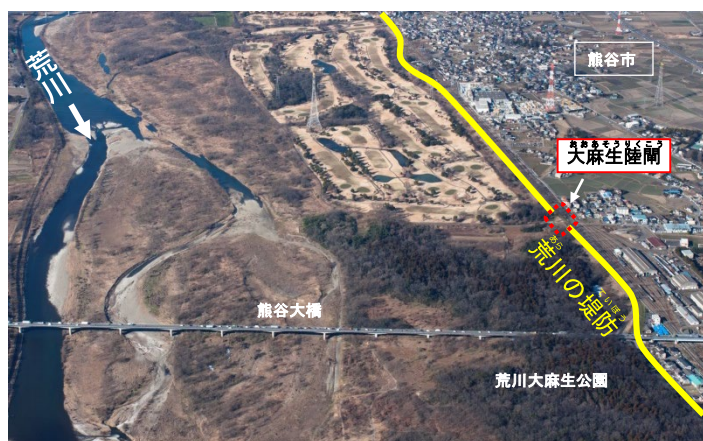
大麻生陸閘周辺の荒川
