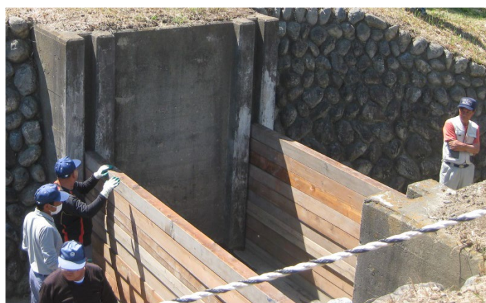
ゲートを閉める訓練中の大麻生陸閘
