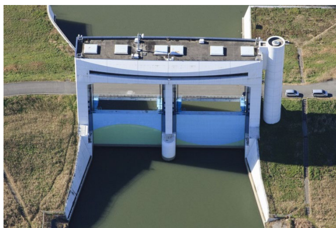
朝霞調節池の下流にある朝霞水門
