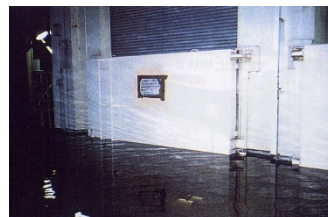
入口の水門使用状況 （平成11年8月洪水）
