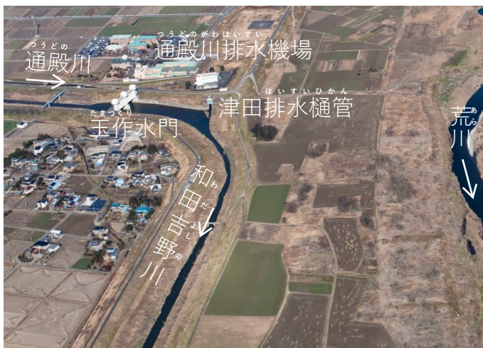
つうどのがわはいすい 通殿川排水機場 空撮
