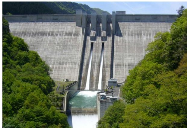
堤体を下流より望む
