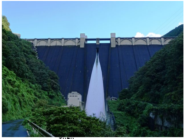
堤体を下流から望む
