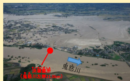
2015 (平成27) 年9月関東・東北豪雨による鬼怒川の破堤の様子
