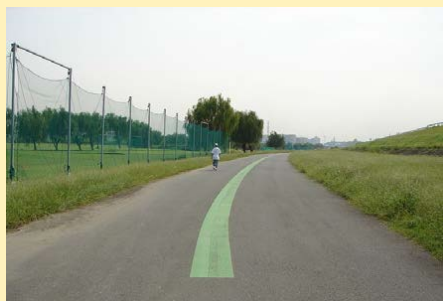
緊急用河川敷道路
