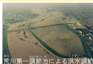
荒川第一調節池による洪水調節
