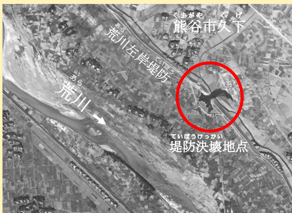
堤防決壊地点の状況 1947（昭和22）年10月米軍空撮
