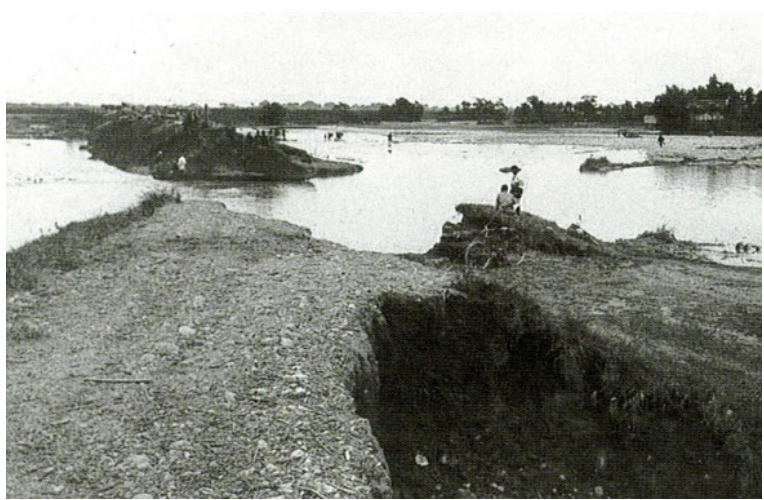
堤防決壊の光景 (熊谷市村岡付近)
