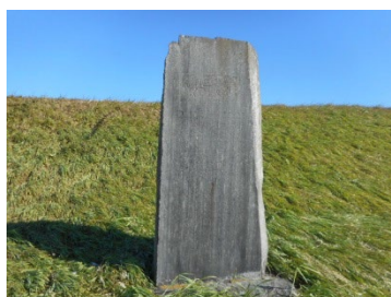
吉見堤の碑（明治43年大洪水時に決壊した堤防の修復碑）
