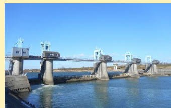
下流側から見た秋ヶ瀬取水堰
